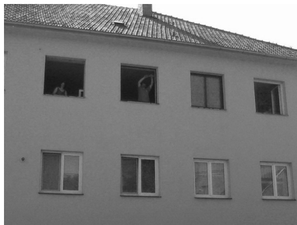
Výměna oken ve víceúčelové budově 2008
