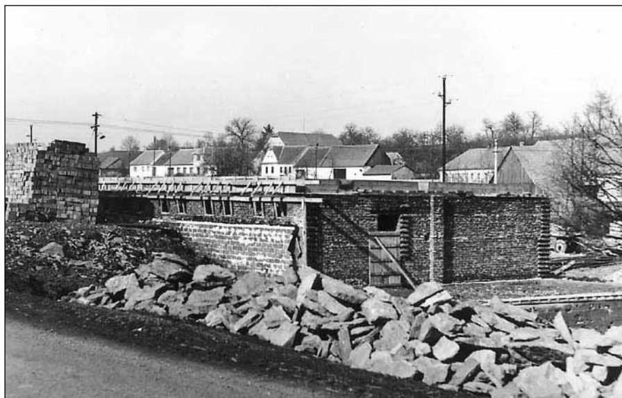
Stavba družstevního domu, 1967
