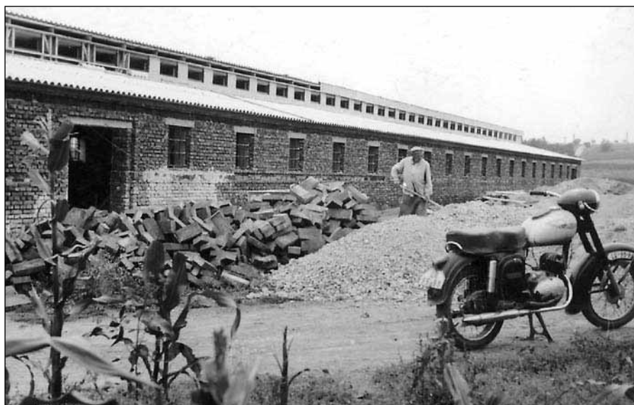
Stavba družstevního kravína, 1965
