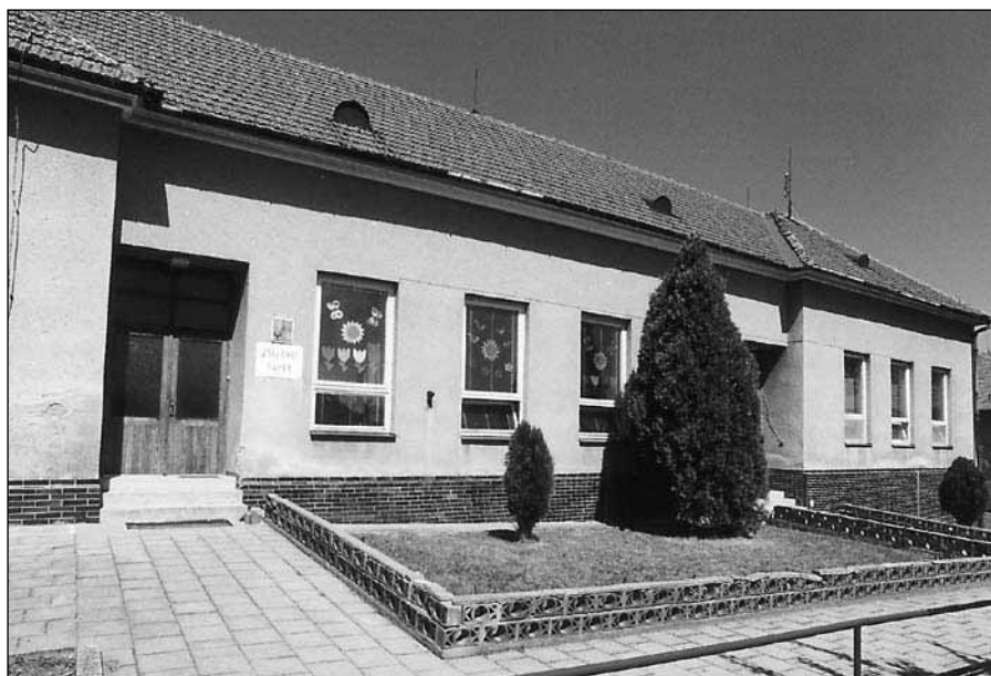
Budova římovské školy
