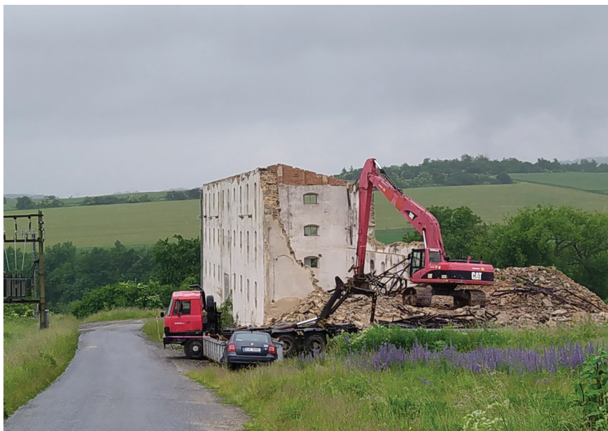
Demolice sýpky na Vískách.
